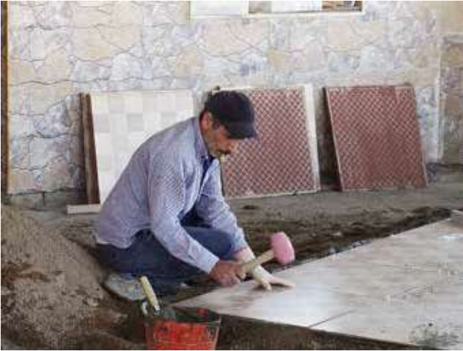
Bau des neuen Kommunikationszentrums in Telskof: Arbeit für viele Christen.
